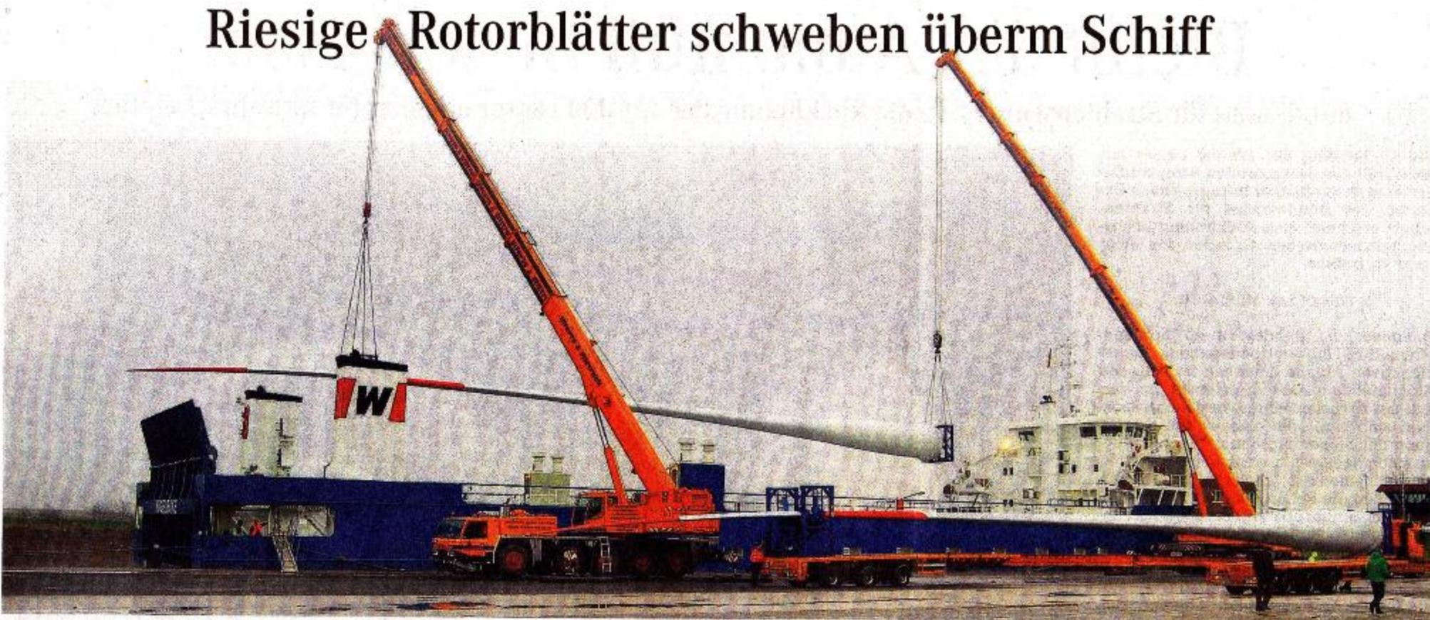
Verladung am Ochtumhafen: Die mehr als 55 Meter langen Rotorblätter werden mit Autokränen aufs Schiff gehoben.
