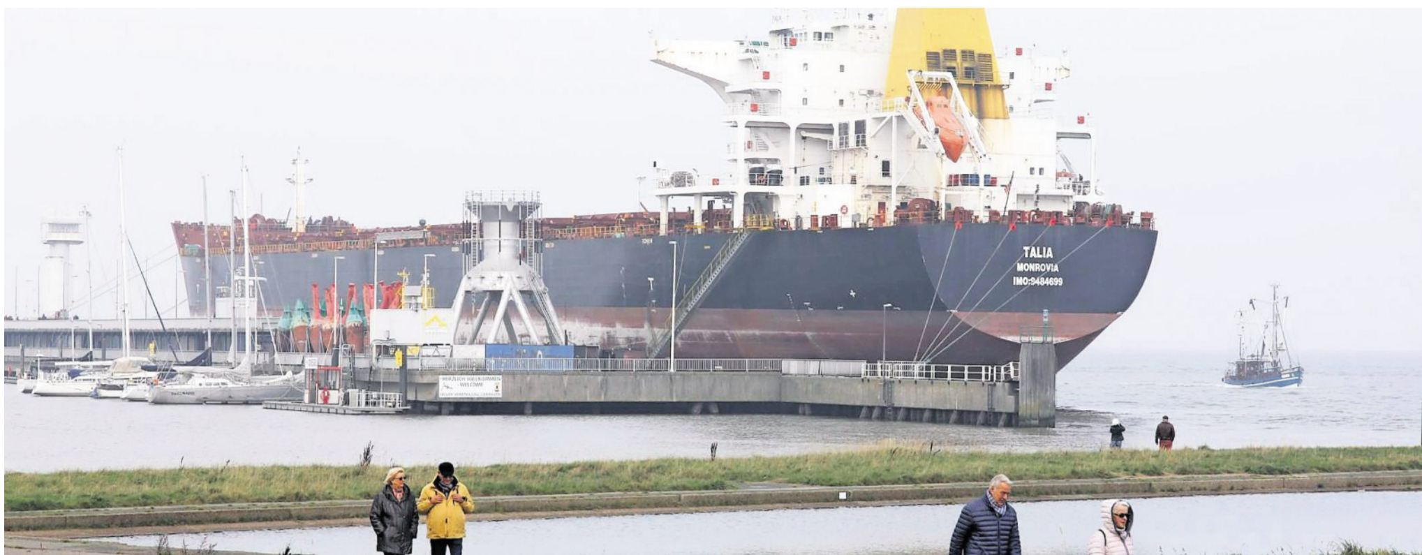
Knapp 230 Meter lang ist der Massengutfrachter „Talia“. Der Schiffsriese füllt die Seebäderbrücke voll aus. Die Reparaturarbeiten dauern noch ein paar Tage.
