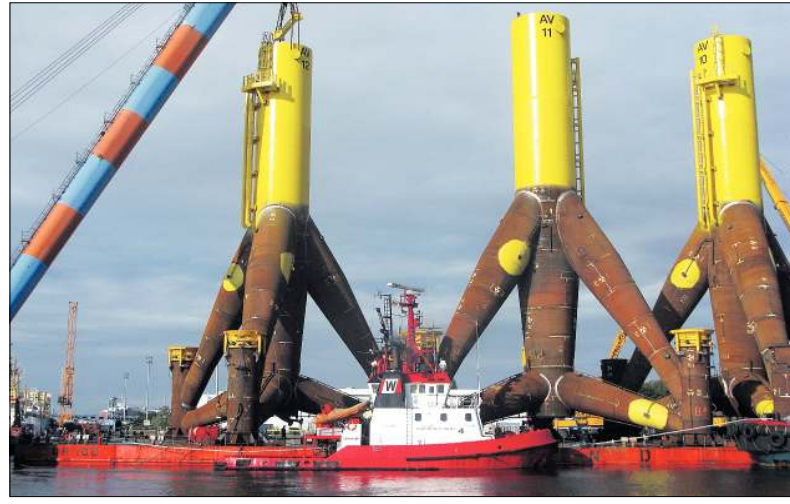
Die Konkurrenz zu BARD, Alpha Ventus, setzt ihre Hoffnungen auf diese in Norwegen produzierten Fundament-Strukturen (Einzelgewicht 710 t). Für die Logistik ist auch hier Wulf verantwortlich. Fotos: Wulf/Wolf
