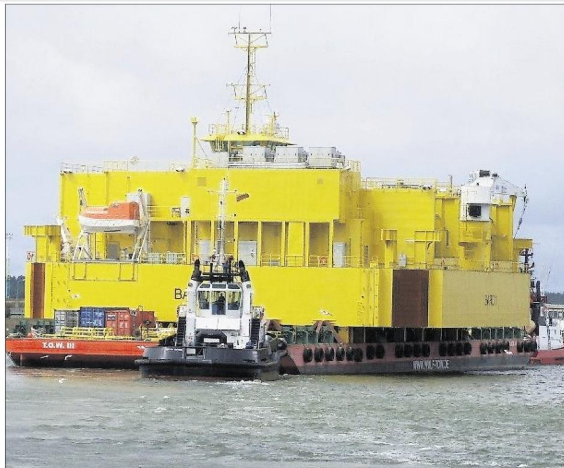
3200 Tonnen bringt die Wohn- und Trafoplattform auf die Waage: Sie ist Bindeglied zwischen dem vor Borkum geplanten Offshore-Windpark der BARD-Gruppe und dem Stromnetz an Land. Die Reederei Wulf schleppt derzeit den Koloss von der Bauwerft im litauischen Klaipeda zum Endausbau nach Belfast. Foto: BARD
