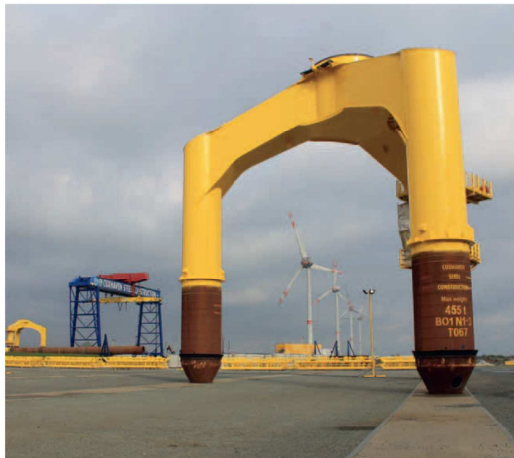
In Cuxhaven stehen die 490 t schweren Tripodfundamente für den Transport bereit.
